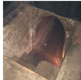
(トンネルの入り口)
